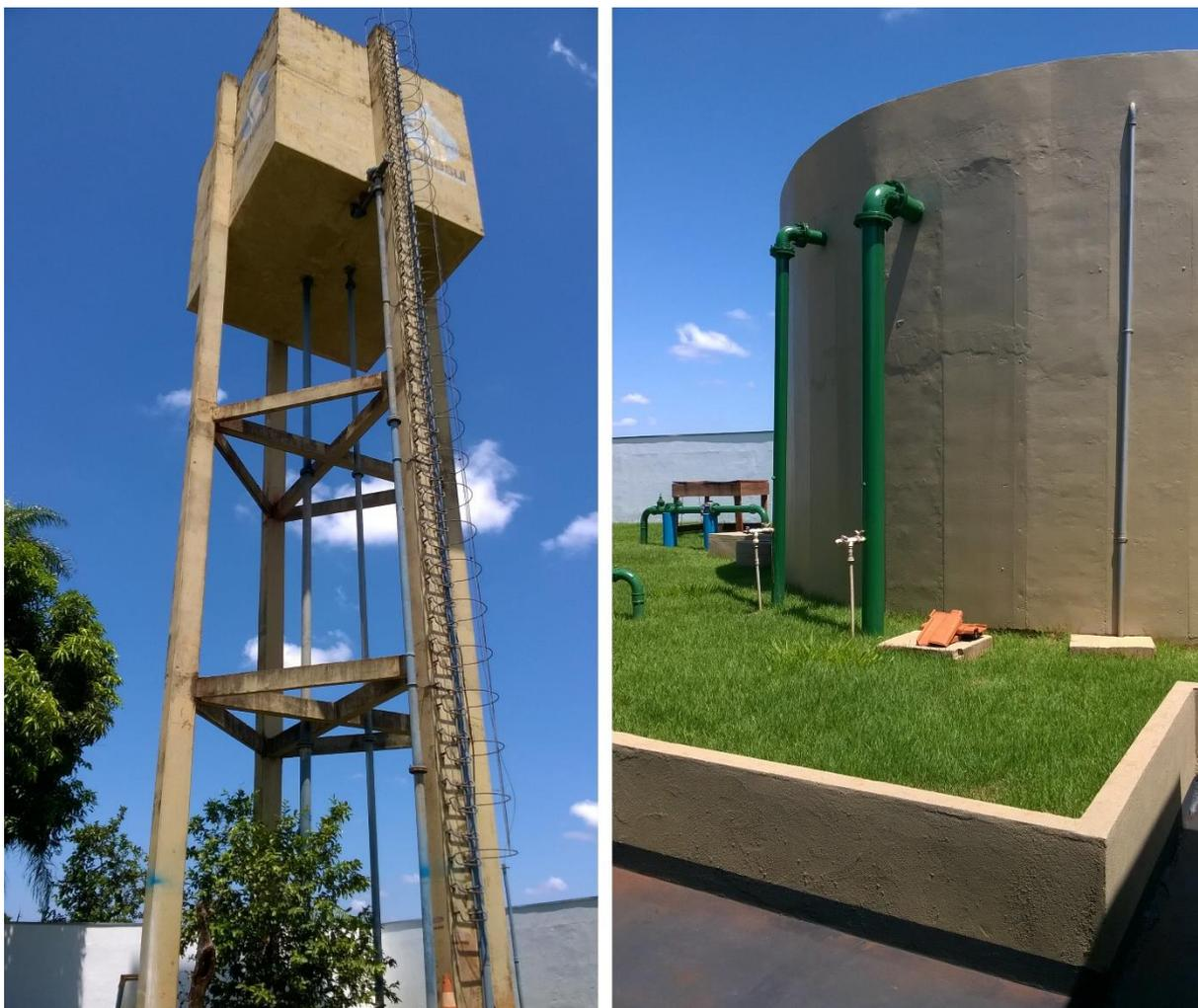
**Figura 33** - Reservatório Elevado à esquerda e Reservatório Apoiado à direita.
