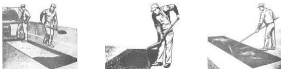
Figura 9: Enchimento de Caixa.
